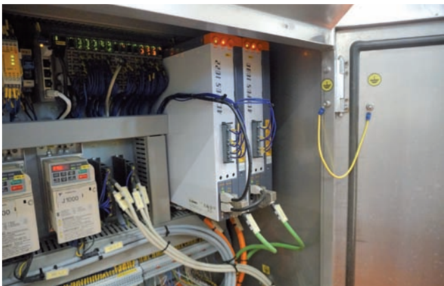
Presun medzi pracovnými stanicami, ako aj pohon časti mechanizmov majú na starosti inteligentné servopohony ACOPOS 1022 a ACOPOS 1090 spoločnosti B&R.
